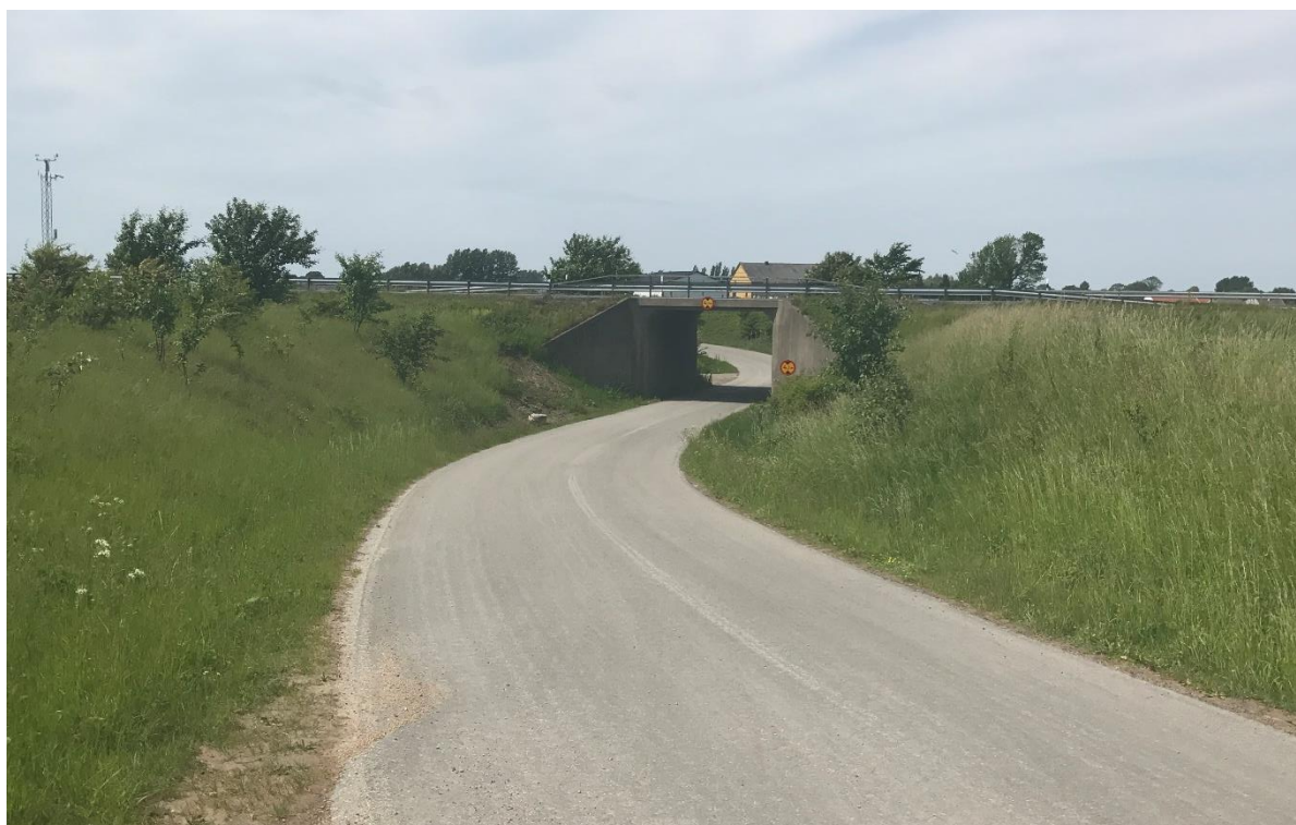
Åkeshögsvägen, tunneln under väg 100.
