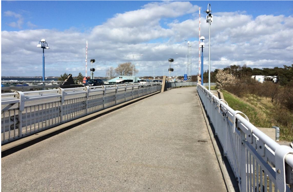
Figur 2. Gång- och cykelväg över bron, separerad från biltrafiken.
