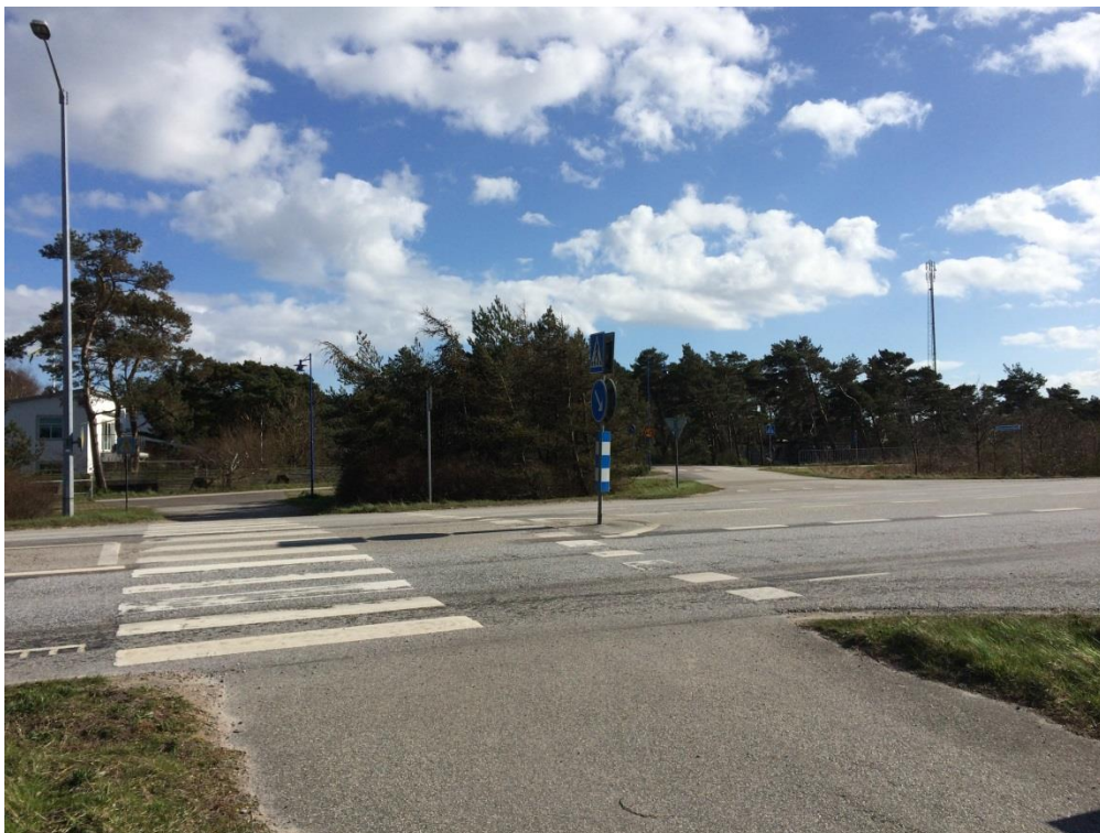
Figur 4. Vy norrifrån över övergångsstället i korsningen samt den södra anslutningen.
