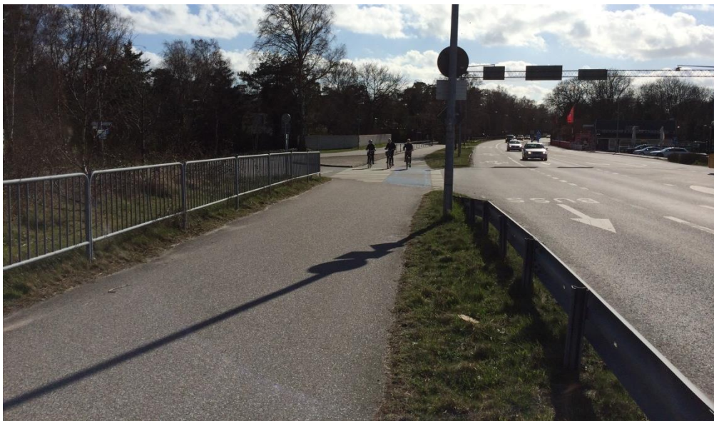
Figur 5. Korsningen Väg 100/Västra Hamnplan sedd österifrån
