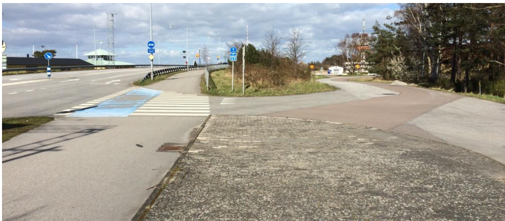
Figur 23. Vy över Västra Kanalvägens anslutning till väg 100.
