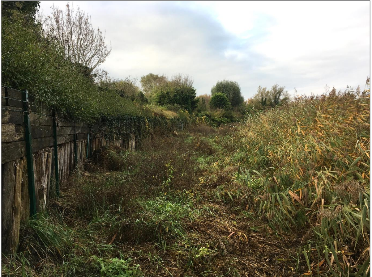
Bild 1. Bilden ovan visar gränsen mellan redan detaljplanelagda tomter (vänster i bild) och havet. Muren till vänster i bild utgör gräns för tomt. Ändringen kommer medge att mur uppförs inne på kvartersmarken (innanför befintlig mur till vänster i bild). 2019-10-22. Fotograf: Johan Mattisson, Vellinge kommun.
