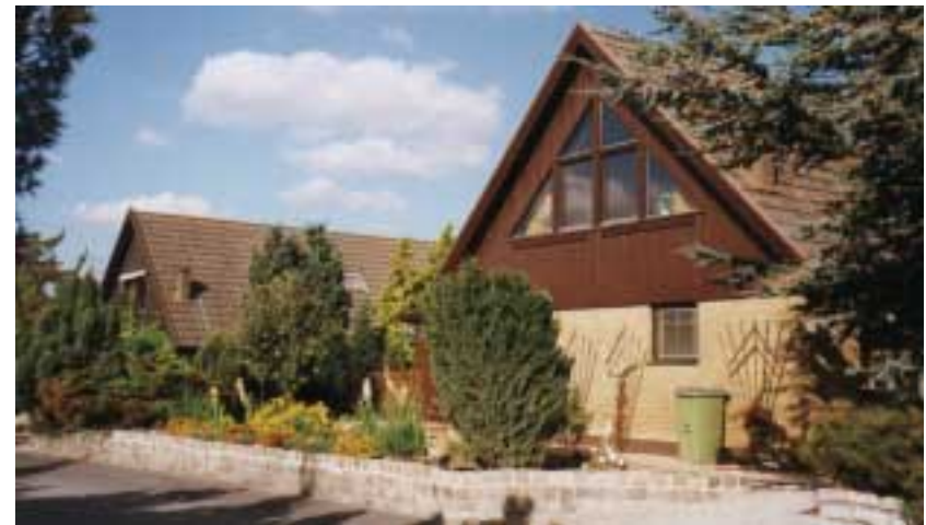
1970-talets dyrkan av underhållsfrihet och rationalitet visade sig i gula eller mörkt rödbruna tegelfasader. Snickerierna var laserade mörkt bruna.
