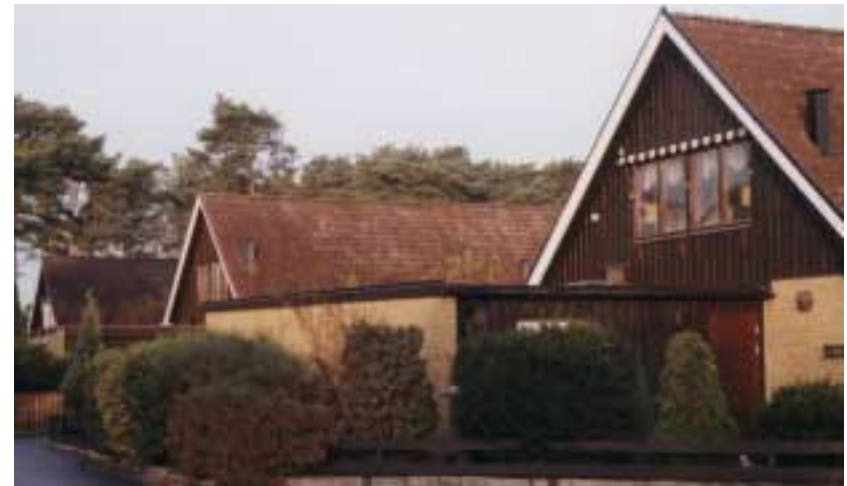
1970-talets dyrkan av underhållsfrihet och rationalitet visade sig i rena gula eller mörkt rödbruna tegelfasader. Snickerierna var laserade mörkt bruna.
