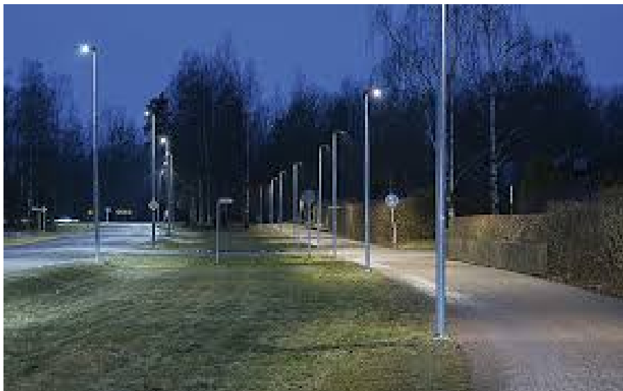
Stolpskog uppstår när spilljus inte längre hjälper till att jämna ut belysning. Bild Johan Elm. Ljuskultur.
